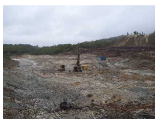
Figura 1: Perforación en la zona de Peña del Hierro, Río Tinto, llevada a cabo por el proyecto IPBSL para identificar el origen de las aguas ácidas del río (Créditos: CAB).
