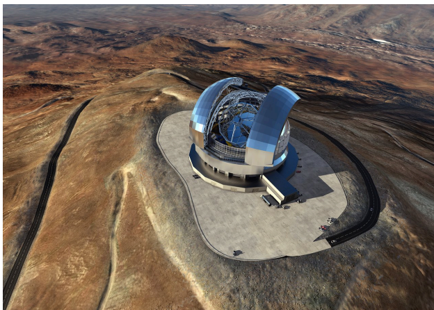
Figura. Ilustración artística mostrando el ELT. El ELT será un telescopio óptico e infrarrojo de 39 metros de diámetro situado en el Cerro Armazones en el desierto chileno de Atacama. El diseño del E-ELT mostrado es preliminar. ©ESO, L. Calçada y ACe Consortium
