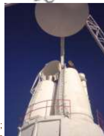
Figura 4. Radiotelescopio de 70 m de diámetro de la Red del Espacio Profundo de NASA en Robledo de Chavela. Detalles de los conos y del espejo secundario.
